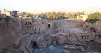
Historische Anlage in Shushtar, Iran, zur Wasserverteilung
